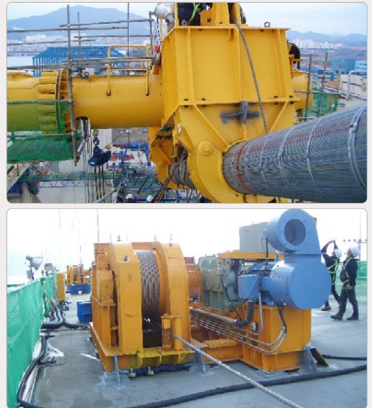
교량설치 기기 및 공사현장설치
